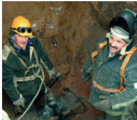
Электрогазосварщик-врезчик В.И.Буняев и слесарь Иванов А.М.
