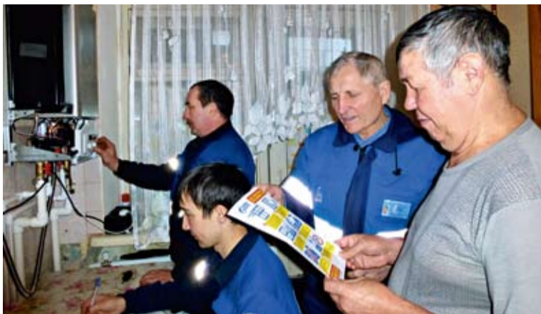
Слесари Ильфат Сабиров, Расим Даниев, мастер Рафиль Исламгалева осуществляют монтаж отопительного оборудования в квартире, одновременно объясняют хозяину правила безопасной эксплуатации
