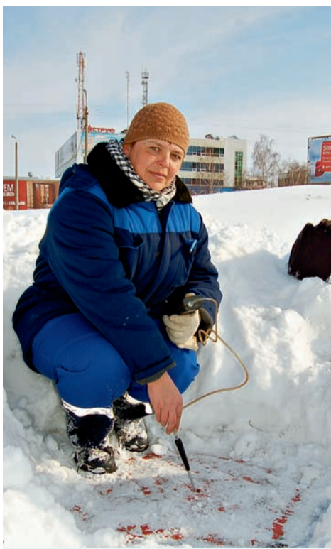
Слесарь по эксплуатации и ремонту подземных газопроводов Галина Федина
