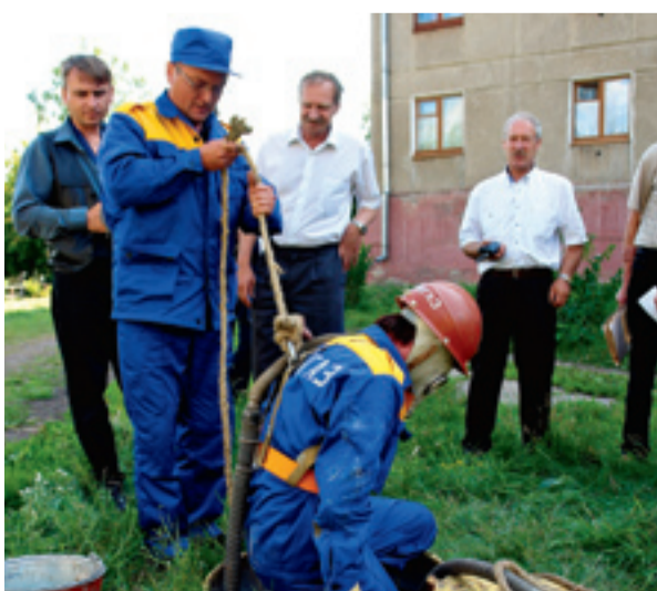
Слесари АДС «Учалыгаза» проверяют колодец
